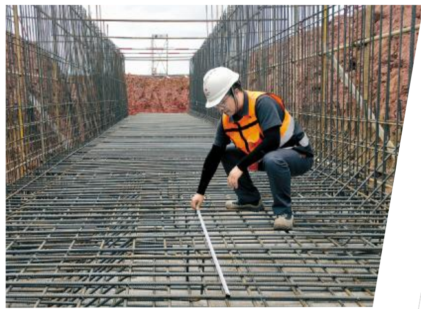
薛磊在项目上检查管沟钢筋绑扎情况
