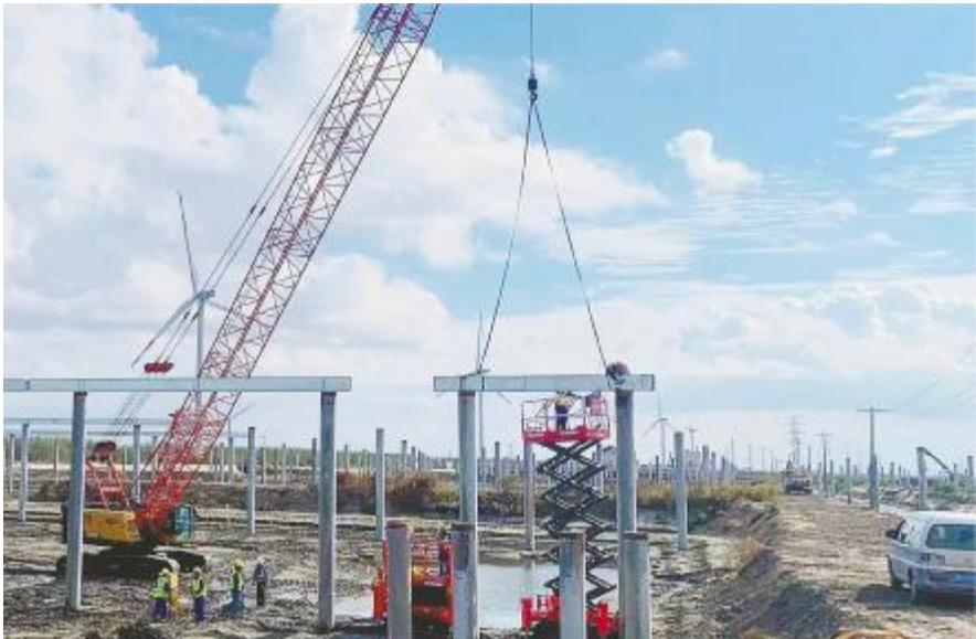
通威如东“渔光一体”四期项目建设现场
