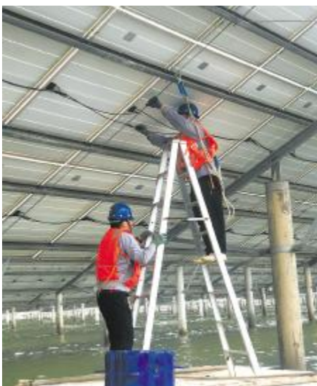
通威山东沾化“渔光一体”电站运维人员检修设备
